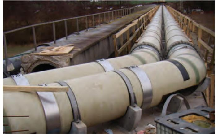
Oberirdische Leitungen die Verschiebungen in Längsrichtung ausgesetzt sind, oder zu Abwinkelungen bzw. Achsversatz neigen, müssen dementsprechend mit Führungen und Haltern versehen werden.
